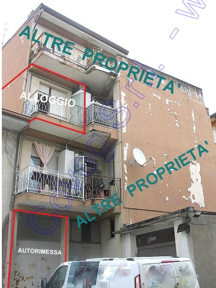
Esterno: lato sud
